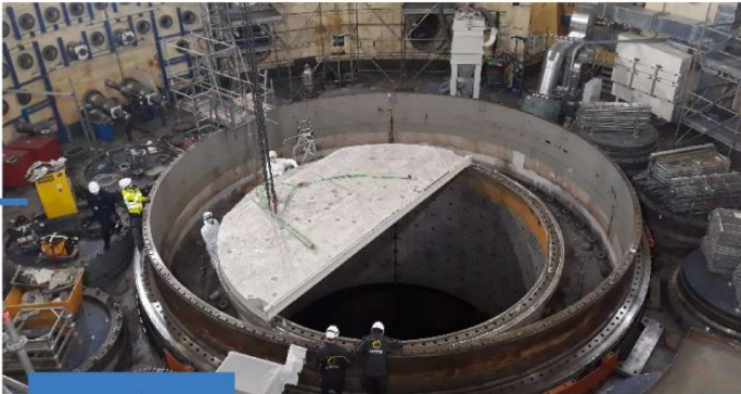
Retrait du Grand Bouchon Tournant (GBT) et la mise en place du SCOT
